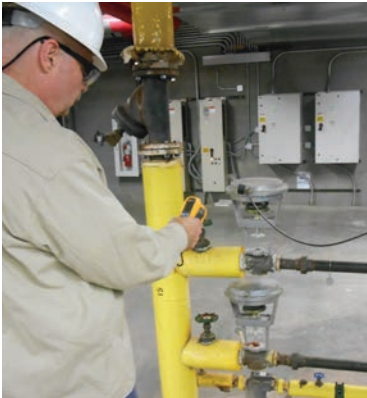
Dampf­temperatur am Eingang des Befeuchterventils messen
