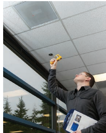
Luftaustrittstemperatur an Luftverteilungskanälen prüfen
