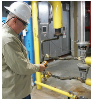
Prüfung des Kondensatabscheidungers, ob er im geöffneten Zustand ausgefallen ist und Dampf unkontrolliert austritt.
